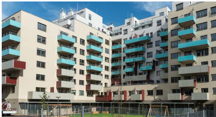
Wohnanlage Handelskei 132a, 1020 Wien, Garage Bitumenbahnen BITUMELIT P-KV-5(P-KV-5B) | 2 650 m 2
